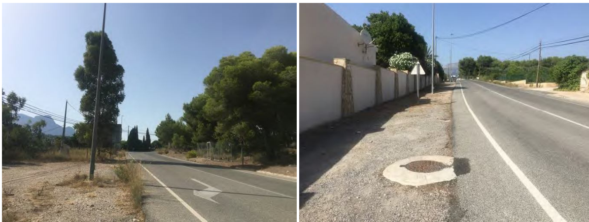
Ilustración 4. Estado actual carretera CV-764.
