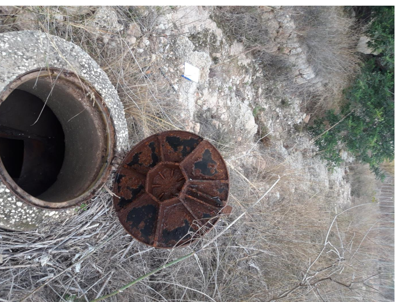
Imagen 3. Pozo de saneamiento EPSAR interior cauce. Profundidad lamina de agua a 1,50 m
