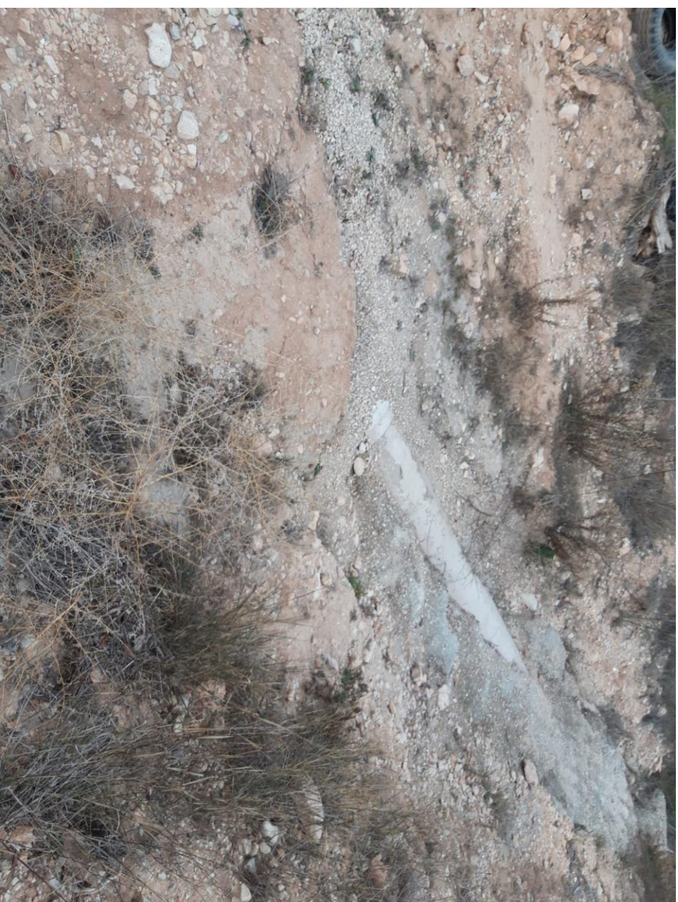
Imagen 6. Detalle del hormigón y del colector
