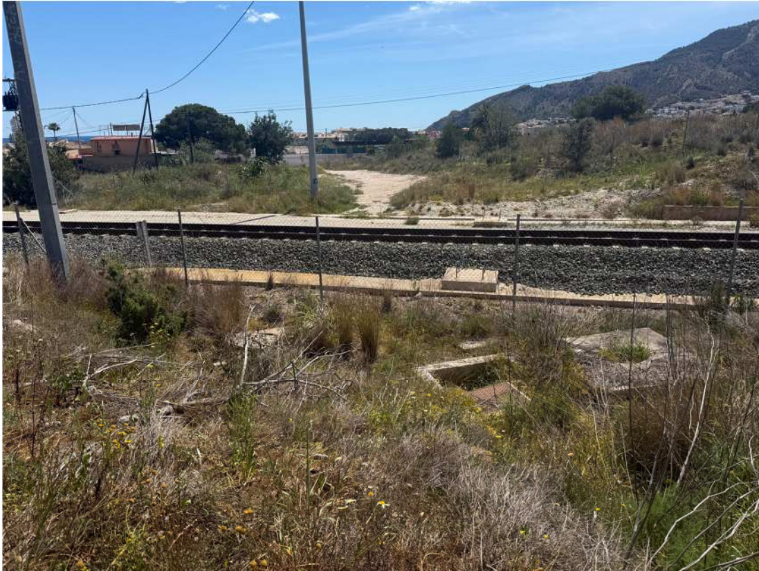
Fotografía 18. Cruce vía de tren
